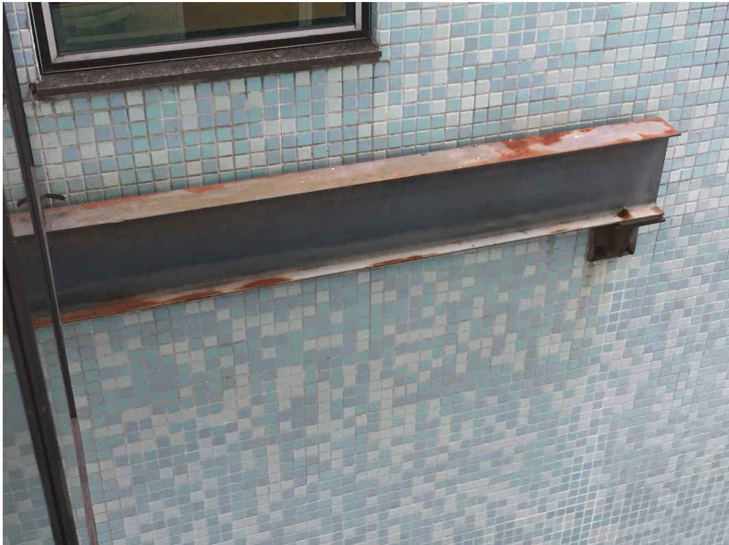
Foto 03 – Vista da viga de apoio direita no Ed. Anexo I
