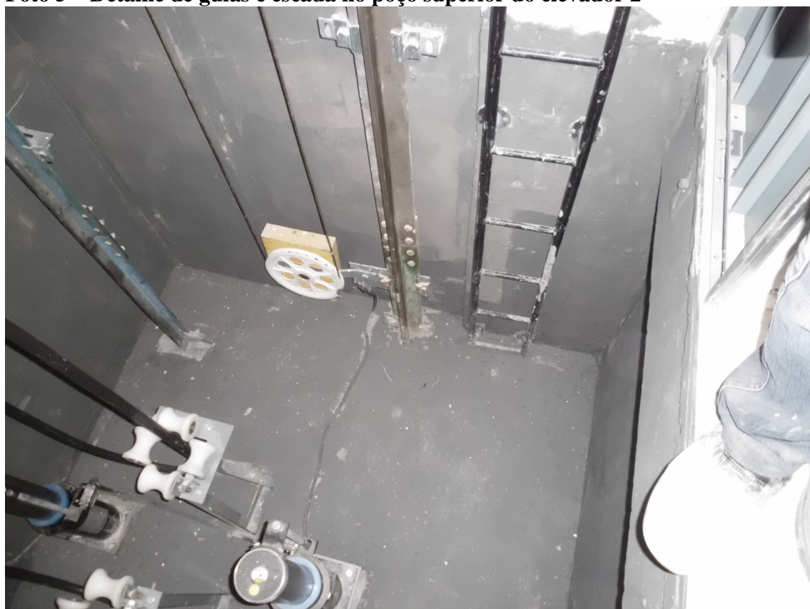
Foto 5 – Detalhe de guias e escada no poço superior do elevador 2
