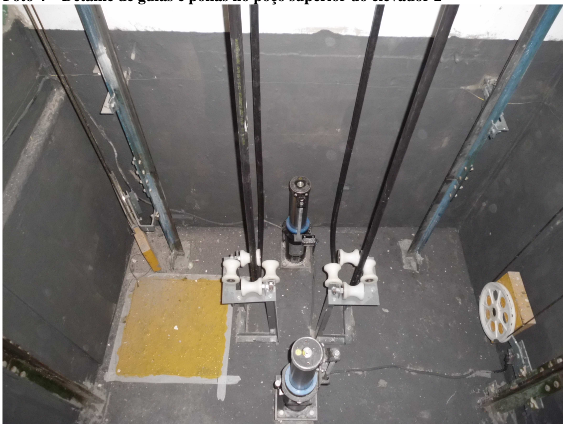
Foto 4 – Detalhe de guias e polias no poço superior do elevador 2
