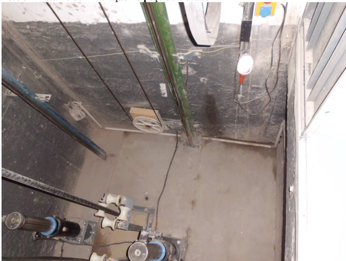
Foto 4 – Detalhe de guias e polias no poço superior do elevador 2
