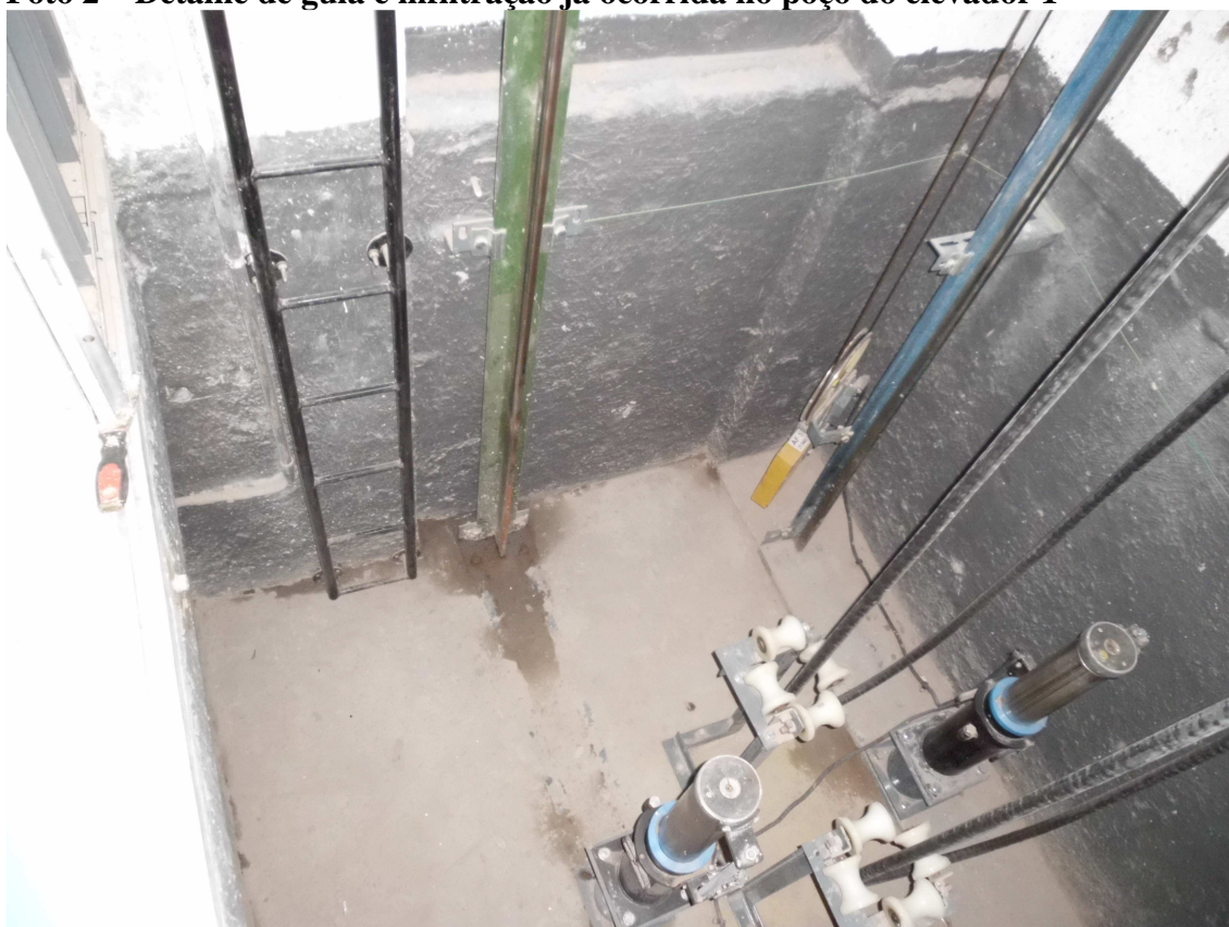
Foto 2 – Detalhe de guia e infiltração já ocorrida no poço do elevador 1
