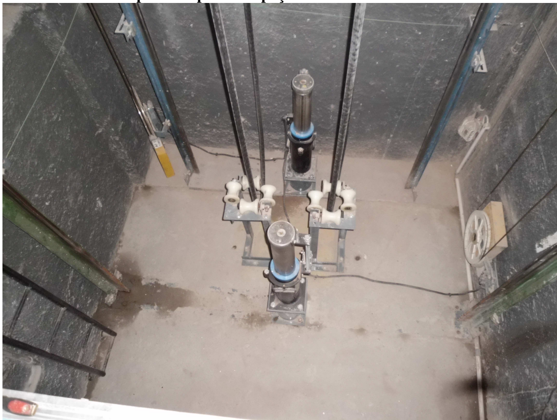
Foto 2 – Detalhe de guia e infiltração já ocorrida no poço do elevador 1
